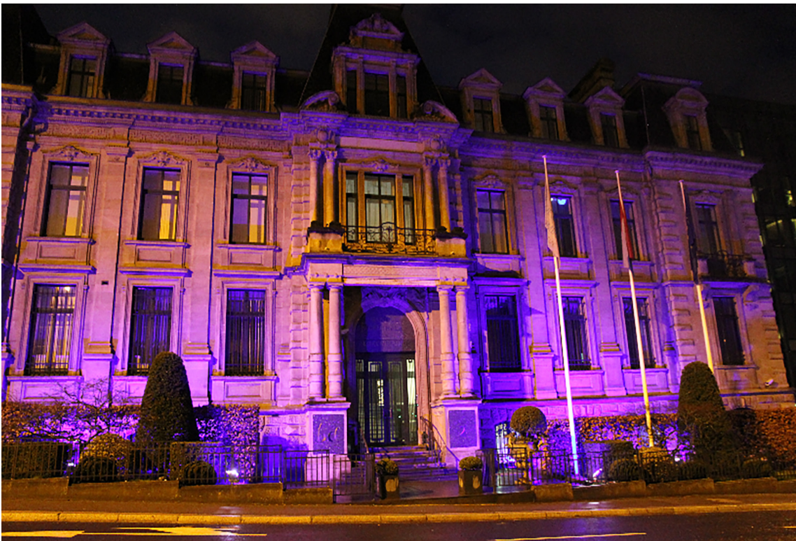
Illumination en bleu de la façade du bâtiment historique. (Photo : BCL)
